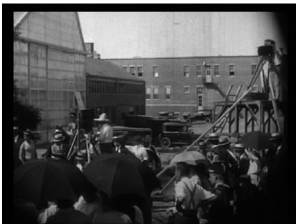
Figura 3. Exterior del complejo del Paragon con uno de los paneles corredizos del edificio principal de cristal abatido hacia arriba
